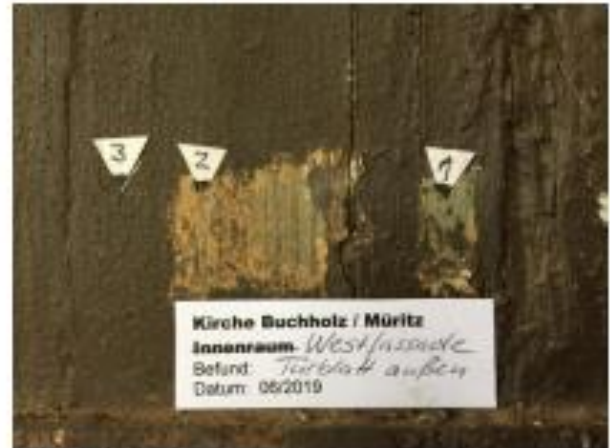
Abb. 15 Westeingang, äußere Tür von außen, Farbschichtenfolge:
