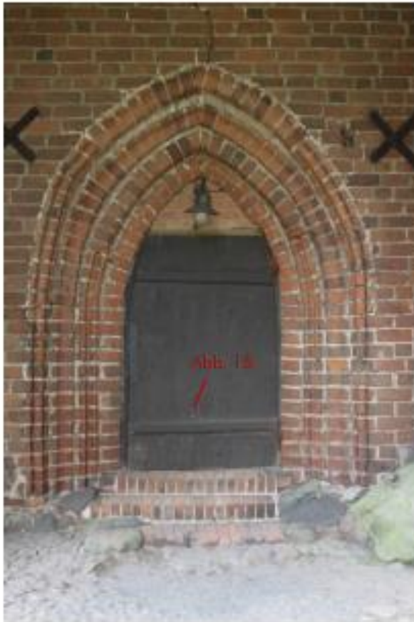
Abb. 14 Westportal mit verschlossener Außentür
