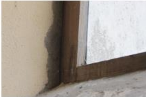
Abb. 8 Fenster in der Südwand (oberhalb der Westempore)
