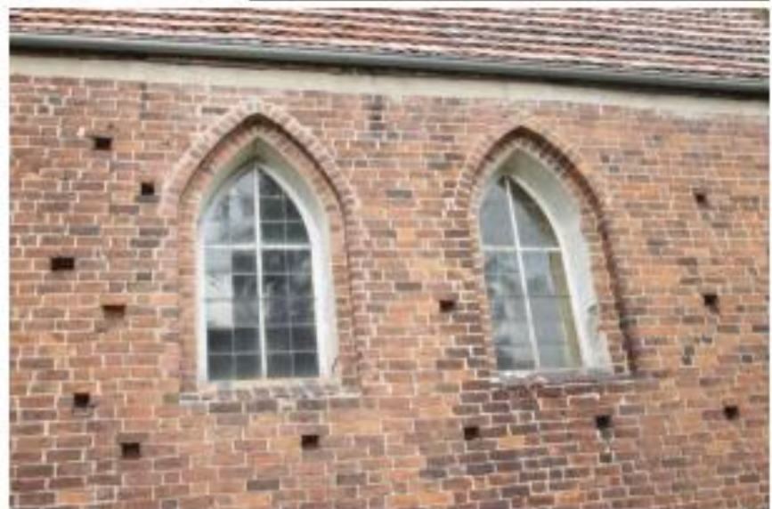
Abb. 9 Fenster in der Nordwand
