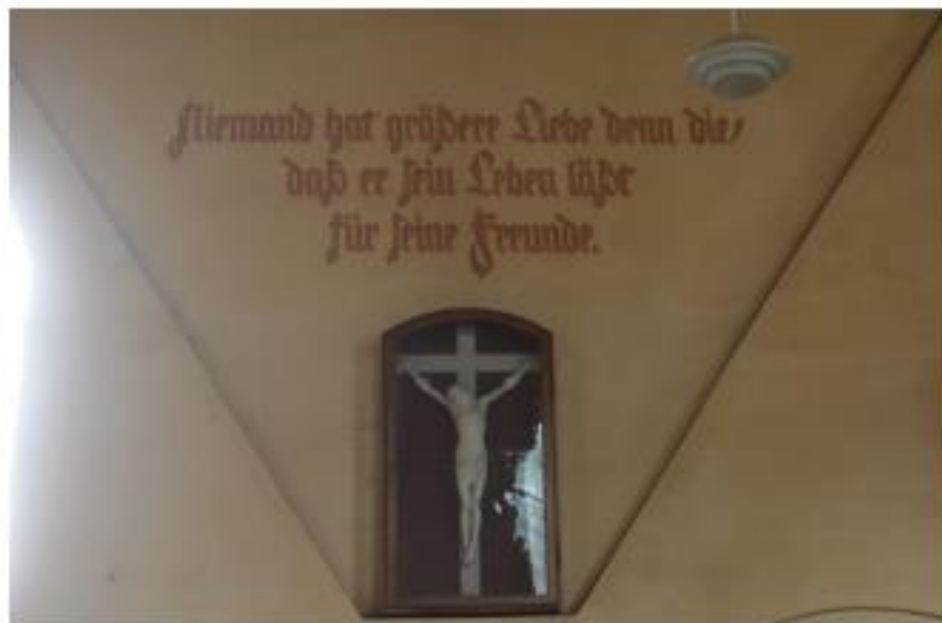
Abb. 7 Schriftzug an der Nordwand, Farbschicht leicht pudern, ansonsten intakt
