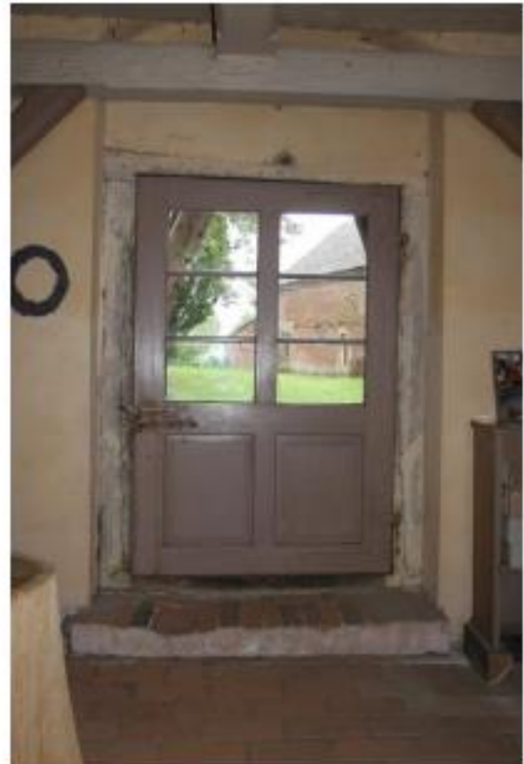
Abb. 12 Westeingang, innere Tür von innen
