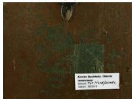
Abb. 19 Türblatt von außen, Farbschichtenfolge: 1 – grün NCS S 7020-G10Y 2 – braun NCS S 7020-Y30R
