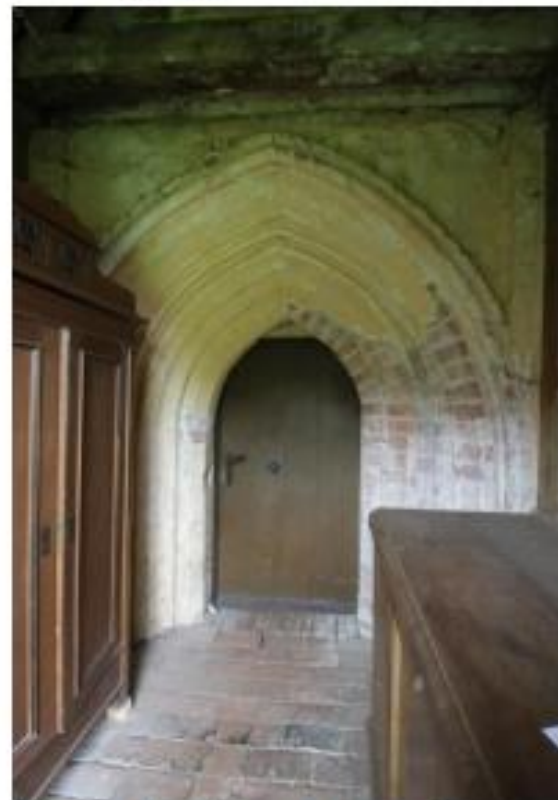
Abb. 17 Nordportal, Eingangstür von außen
